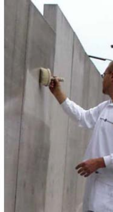
Nach der zweiten Applikation wird NCC Antigrffiti mit einem Pinsel verstrichen.
